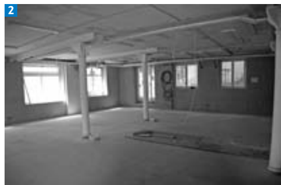
1 Von der alten Werkstatt ... 2 ... zum neuen Büroloft
