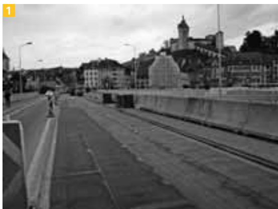
1 Mittelbereich der Brücke mit Munot im Hintergrund
