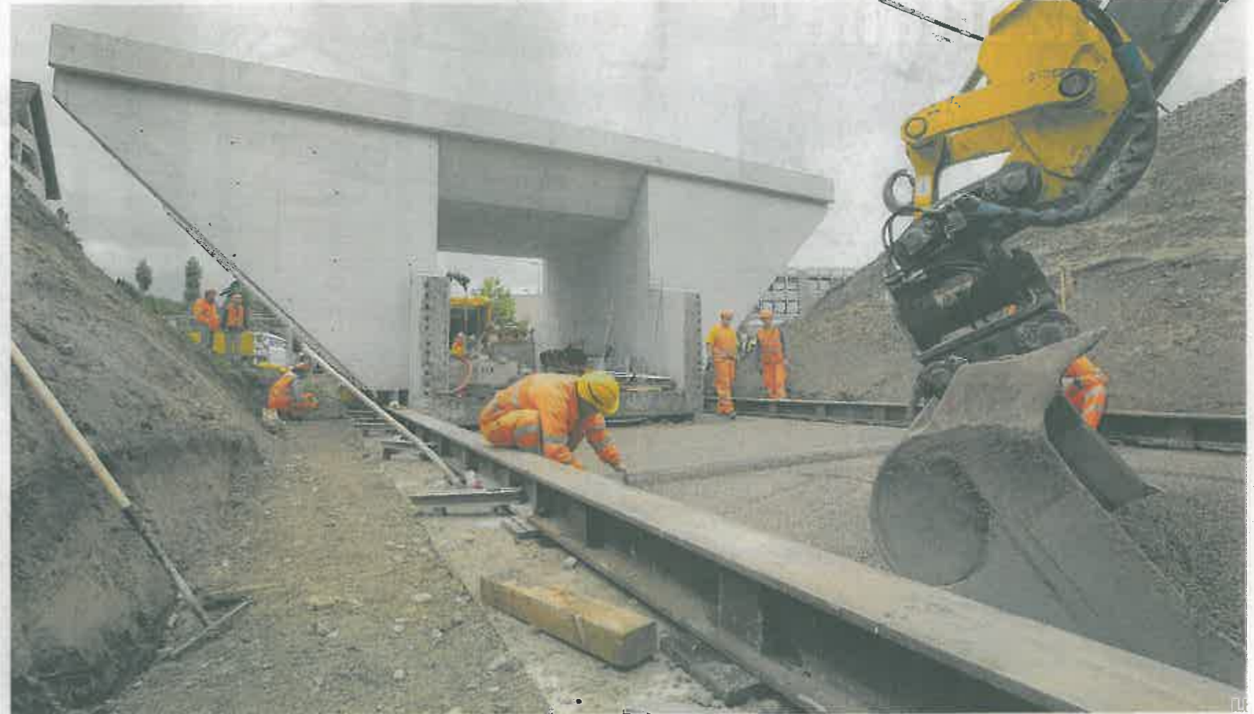
Auf Verschubbahnen wurde die Unterführung Millimeter um Millimeter vorwärts geschoben. Bild: Imre Mesterhazy
